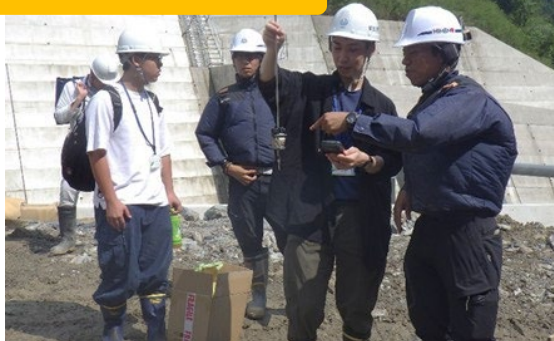
熊谷第4堰堤 施工体験
