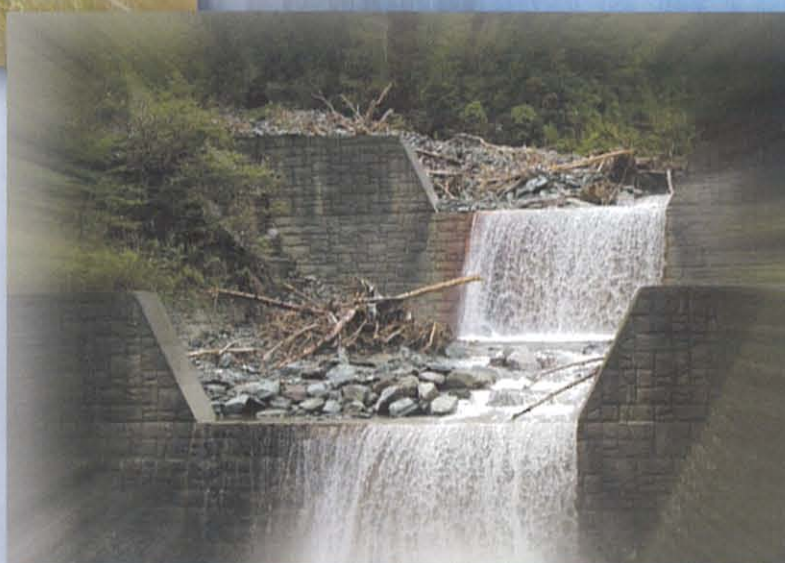
朝谷第2堰堤（高知県大川村）
