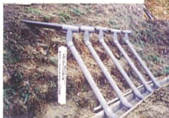
↑横ボーリング工
