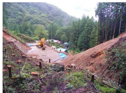
掘削工 上流側より
