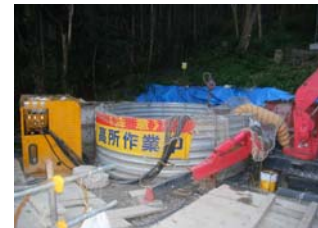
防護ネット設置状
