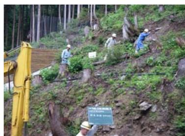
(写真3) 掘削法面養生
