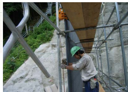
写真7(クランプ取外し)
