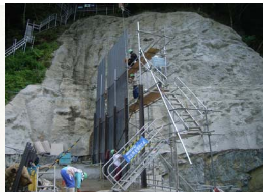
写真6(鉄筋立て込み)
