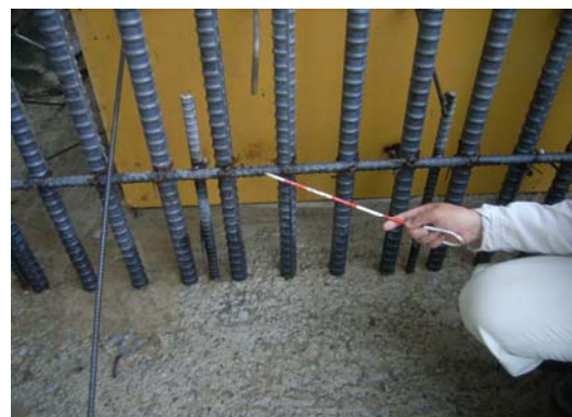
写真9(鉄筋結束)
