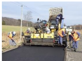
低炭素アスファルト (CO 2 排出量7~18%削減)
