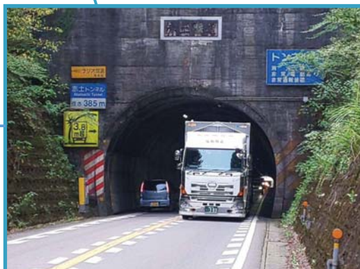
通行支障トンネル（赤土トンネル）がある 国道 33 号
