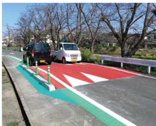
【ハンプ設置状況（松山市東石井地区）】
