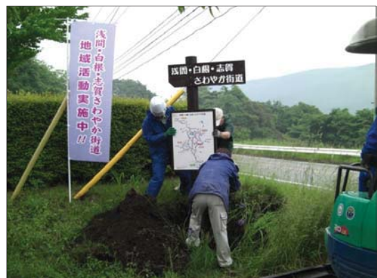
建て込み作業
