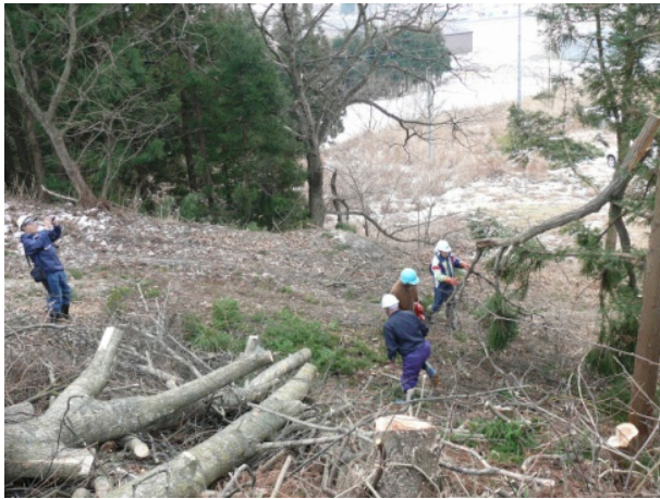
景観阻害木の伐採作業
