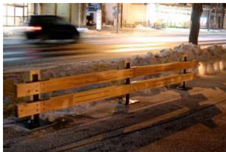
写真⑤ 秋田杉集成材と鋼材のハイブリッドガードレール
