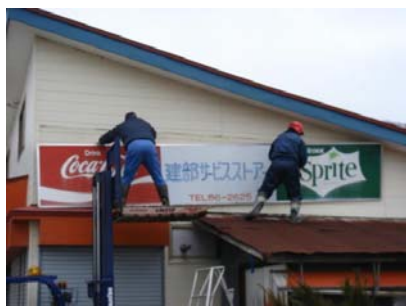
①看板の撤去
