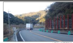
写真1 線形の厳しい箇所
