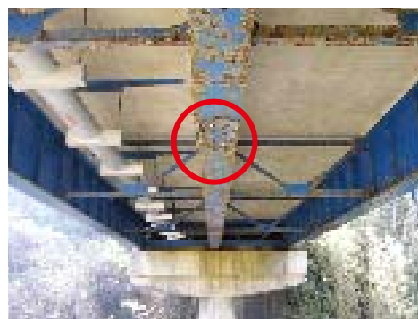
高齢化により損傷の著しい橋梁（高知県：相間川橋、1967年架設）
