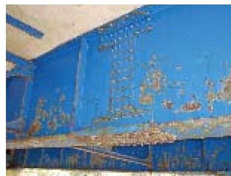
高齢化により損傷の著しい橋梁（高知県：相間川橋、1967年架設）
