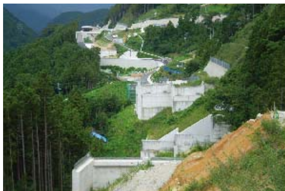
三坂第一トンネル高知側坑口付近
