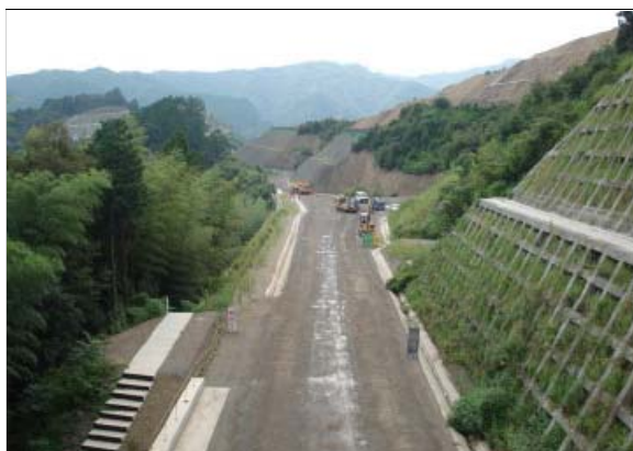
四国横断自動車道(須崎西～窪川) 高知県中土佐町和田付近
