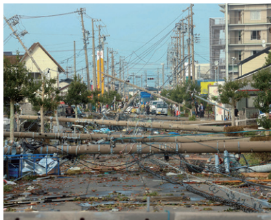
令和7年 竜巻による静岡県牧之原市の被災状況 (中日新聞社提供)
