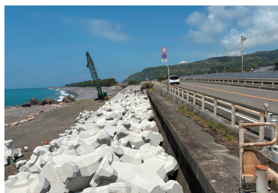
国道55号 高知県安芸郡安田町 現在の状況
