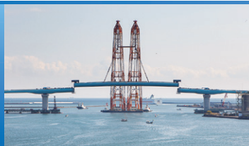
四国横断自動車道 新町川橋(徳島県)
