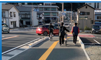
国道56号 大洲交差点改良(愛媛県)
