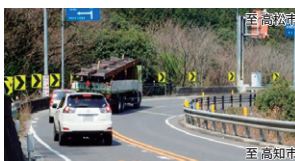
写真②:高知側線形不良箇所
