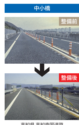
高知県 高知南国道路
