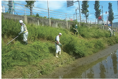
安全な走行空間の確保や、農作物への被害防止のため、繁茂状況に応じて除草を実施
