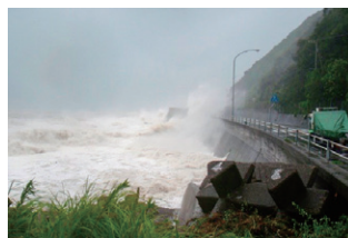
国道55号 越波状況
