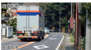
写真①:高松側線形不良箇所
