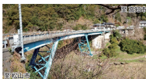
写真②:橋梁全景
