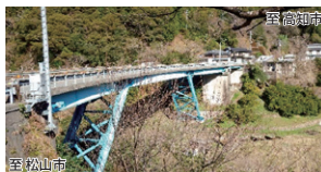
写真②:橋梁全景
