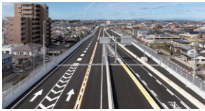
松山外環状道路空港線(余戸南IC~東垣生IC)開通の状況
