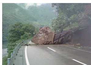
H22.8.16 岩盤崩壊の状況
