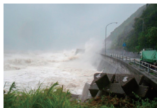
国道55号 越波状況
