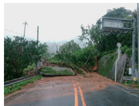
H30.7.7 法面崩壊による災害 愛媛県宇和島市吉田町白浦
