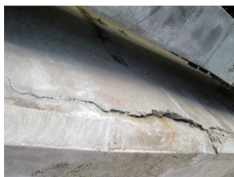
老朽化により損傷の著しい橋梁(例)
