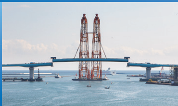
四国横断自動車道 新町川橋(徳島県)
