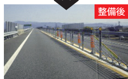
高知県 高知南国道路
