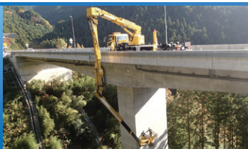
国道33号 つづら川第1橋点検(愛媛県)
