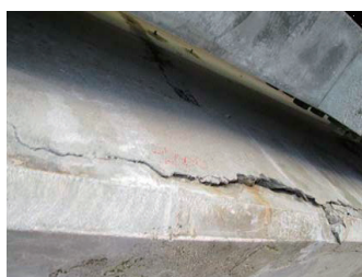
老朽化により損傷の著しい橋梁(例)
