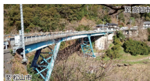
写真②:橋梁全景
