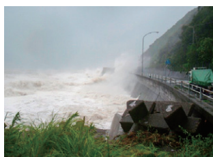
国道55号 越波状況
