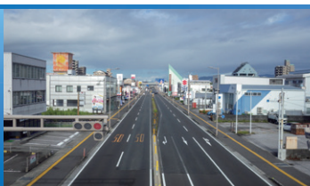
国道32号 高須地区電線共同溝(高知県)
