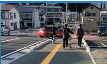
国道56号 大洲交差点改良(愛媛県)
