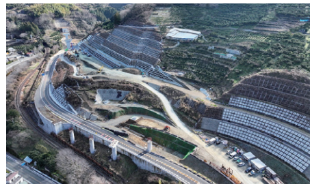
「地域高規格道路」 国道197号夜昼道路（愛媛県）
