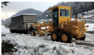
除雪車により車両を牽引
