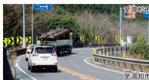
写真②:高知側線形不良箇所
