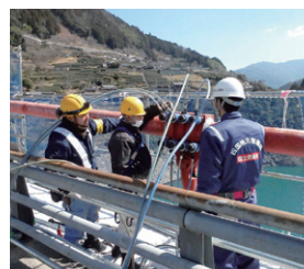
修繕代行の実施状況（大渡ダム大橋）
