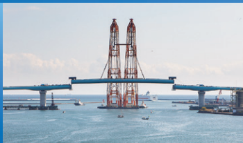
四国横断自動車道 新町川橋(徳島県)
