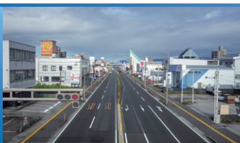
国道32号 高須地区電線共同溝(高知県)
