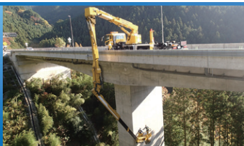
国道33号 つづら川第1橋点検(愛媛県)
