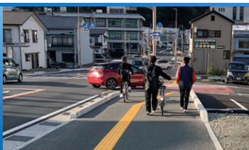
国道56号 大洲交差点改良(愛媛県)
