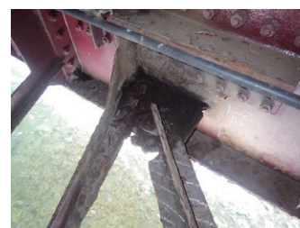
老朽化により損傷の著しい橋梁(例)
