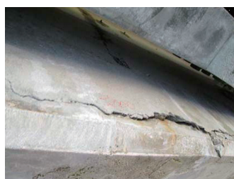
老朽化により損傷の著しい橋梁(例)
