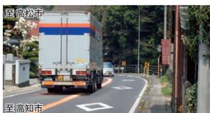
写真①:高松側線形不良箇所
