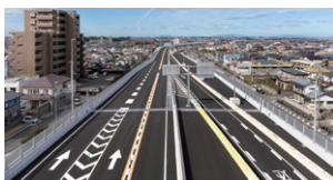
松山外環状道路空港線(余戸南IC～東垣生IC)開通の状況
