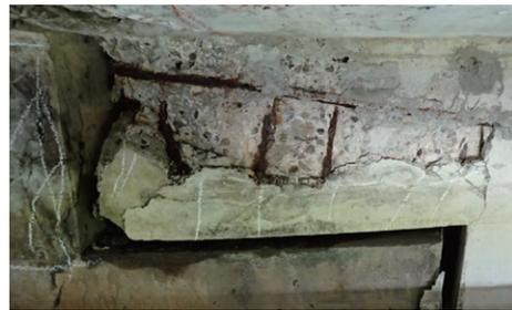
主桁の剥離・鉄筋露出（例）
