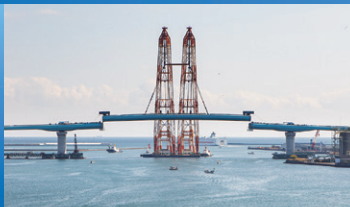
四国横断自動車道 新町川橋(徳島県)
