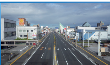
国道32号 高須地区電線共同溝(高知県)
