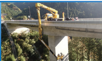
国道33号 つづら川第1橋点検(愛媛県)
