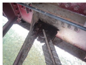
老朽化により損傷の著しい橋梁(例)
