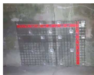
【FRPネット設置】
