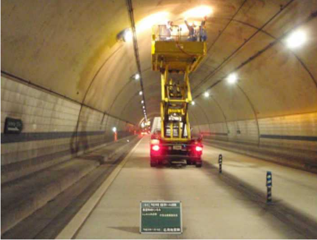
近接目視によるトンネル点検
