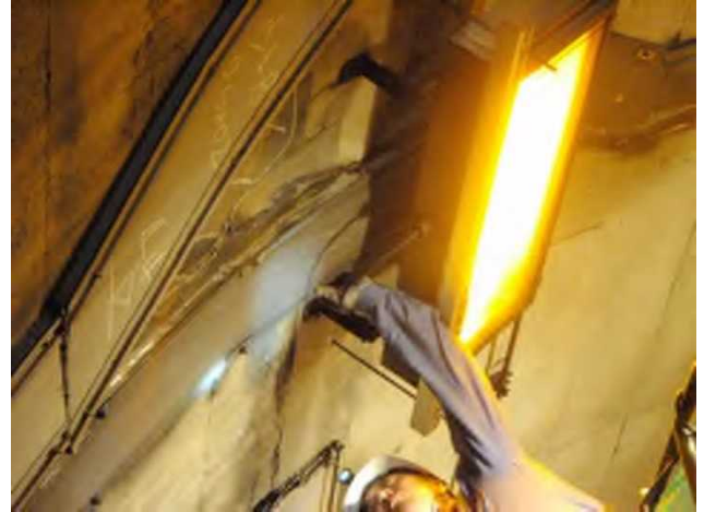
附属物の点検状況
