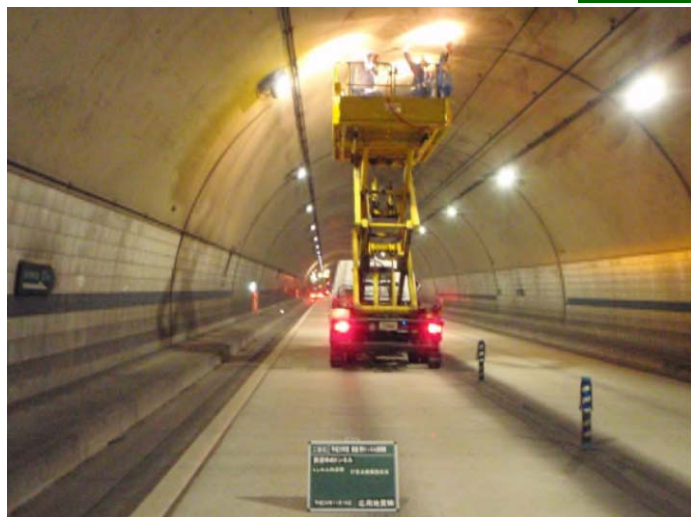
近接目視によるトンネル点検
