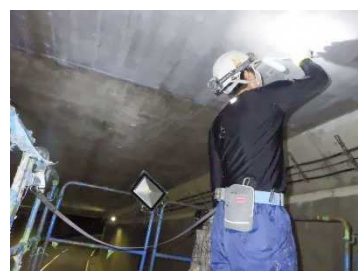
【表面含浸(施工中)】
