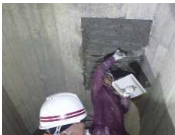
【左官工法(施工中)】
