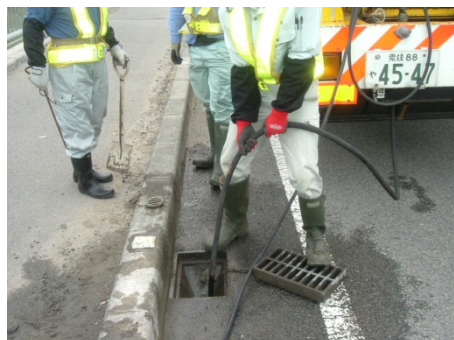
排水柵の清掃
