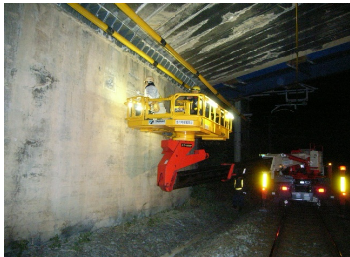
軌陸車による跨線橋の定期点検
