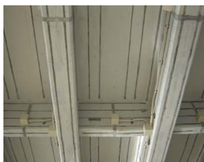
電気防食工法
