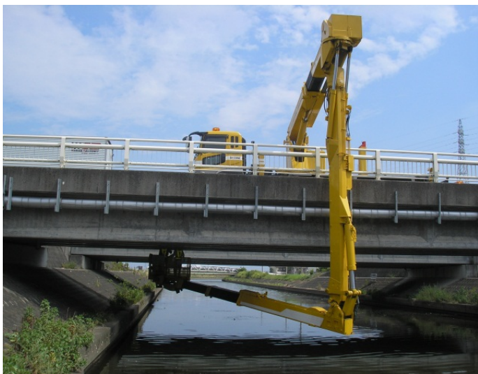
橋梁点検車による定期点検
