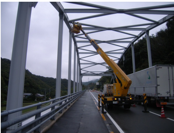
高所作業車による定期点検
