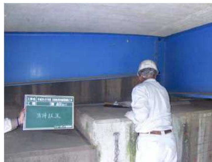
支承周りの清掃
