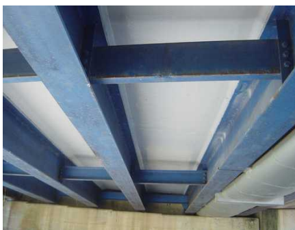
炭素繊維シート接着工法
