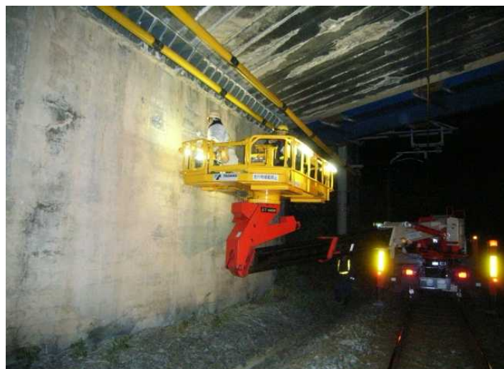
軌陸車による跨線橋の定期点検
