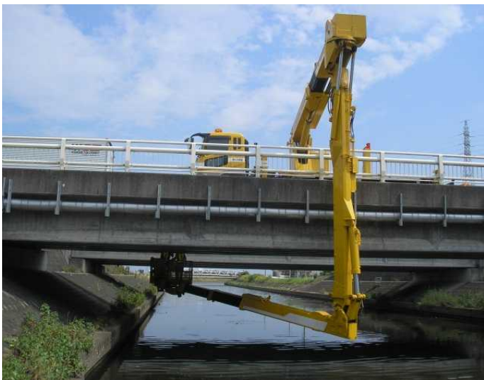
橋梁点検車による定期点検
