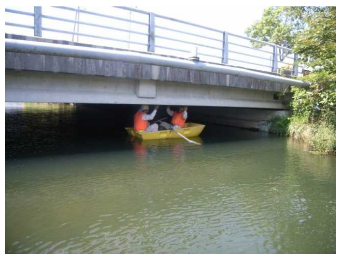
船による定期点検
