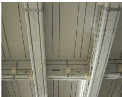
電気防食工法
