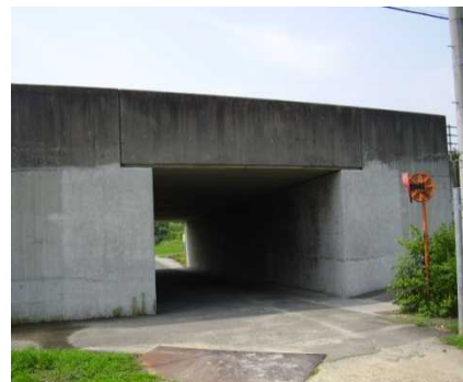
リチウムイオン内部 圧入工法
