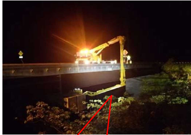
大型橋梁点検車
