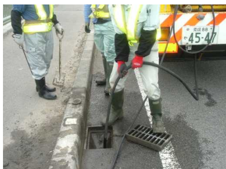
排水柵の清掃
