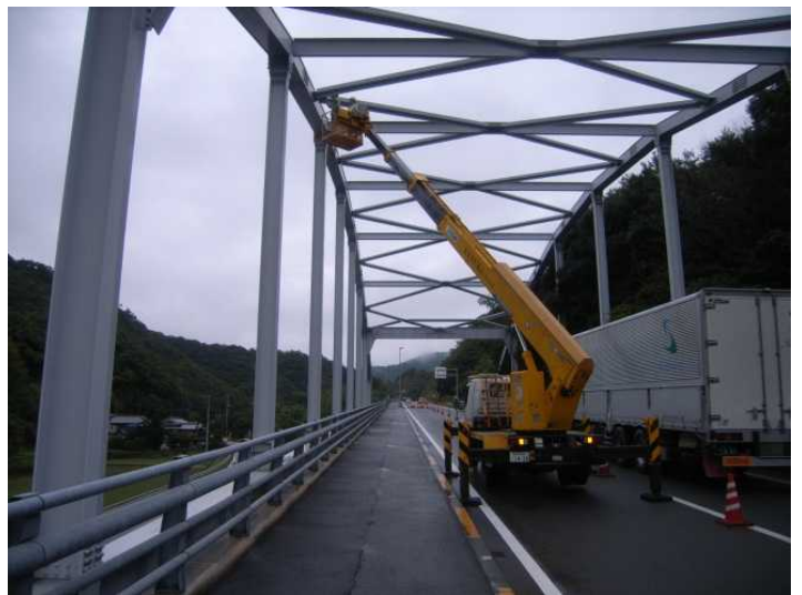
高所作業車による定期点検
