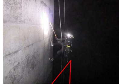
ロープ高所作業
