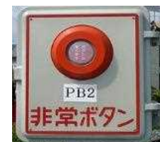
非常押しボタン
