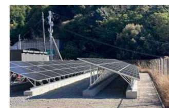
太陽光発電施設の設置
