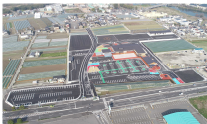
徳島県板野郡板野町 道の駅「いたの」
