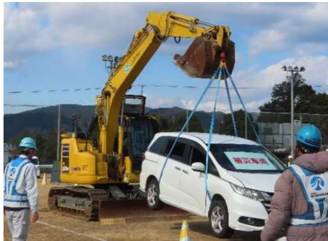
図 6-2 訓練実施状況 (バックホウによる車両移動：土佐国道事務所)
