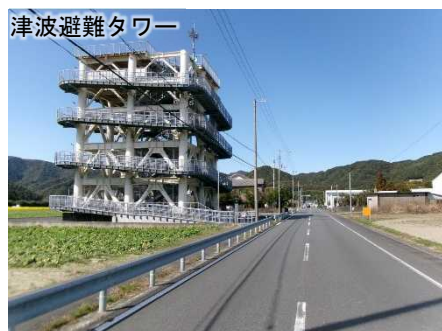
①津波浸水が想定される国道321号 (土佐清水市大岐地区)
