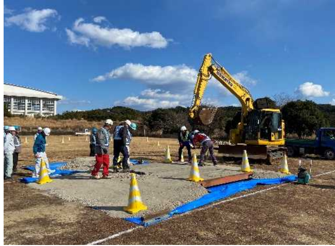
図 6-1 訓練実施状況 (段差の応急復旧：土佐国道事務所)
