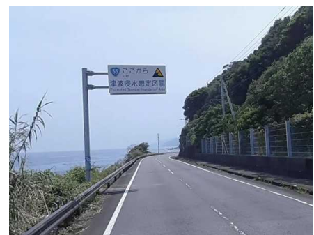
②津波浸水が想定される国道55号 (安芸郡東洋町)
