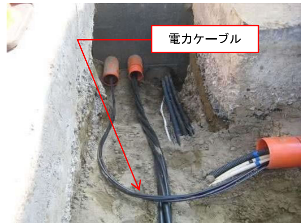
電力ケーブルの引込状況
