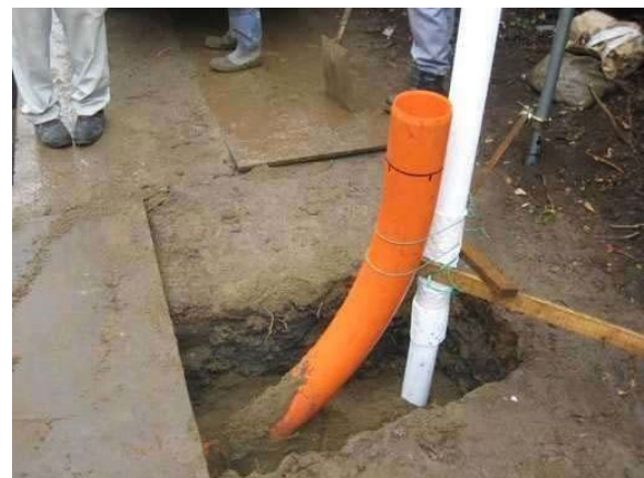
引込み管の立ち上げ状況
