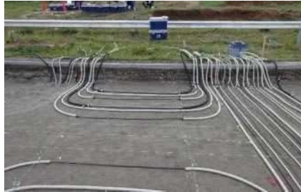
ケーブルを舗装に埋設
