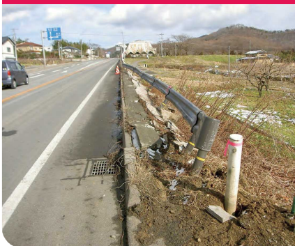
ガードレール・標識等の損傷
