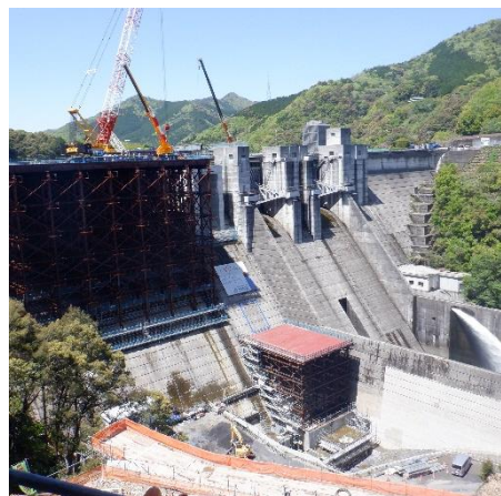
野村ダム改良工事(愛媛県)
