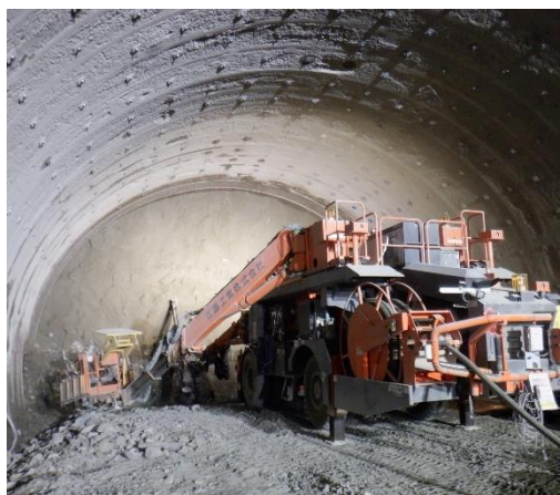
下大野トンネル工事(徳島県)
