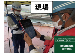
仮設作業架台確認
