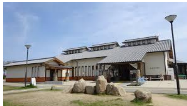
④道の駅 源平の里むれ
