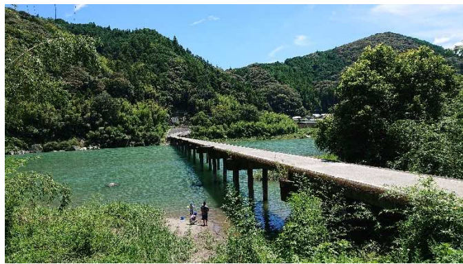
名越屋沈下橋
