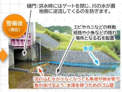
樋門：洪水時にはゲートを閉じ、川の水が農地側に逆流してくるのを防ぎます。
