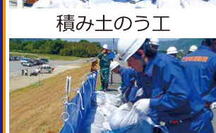
積み土のう工
