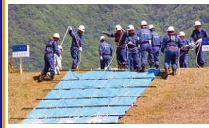
シート張り工
