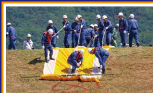
水防マット工
