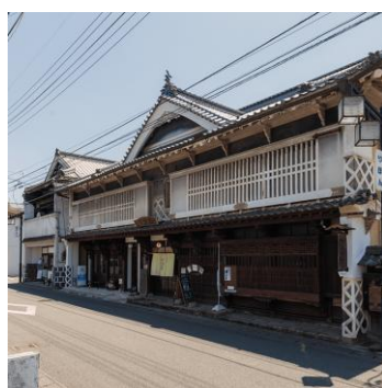
きゅうしも は が け 旧下芳我家住宅・隠居屋
