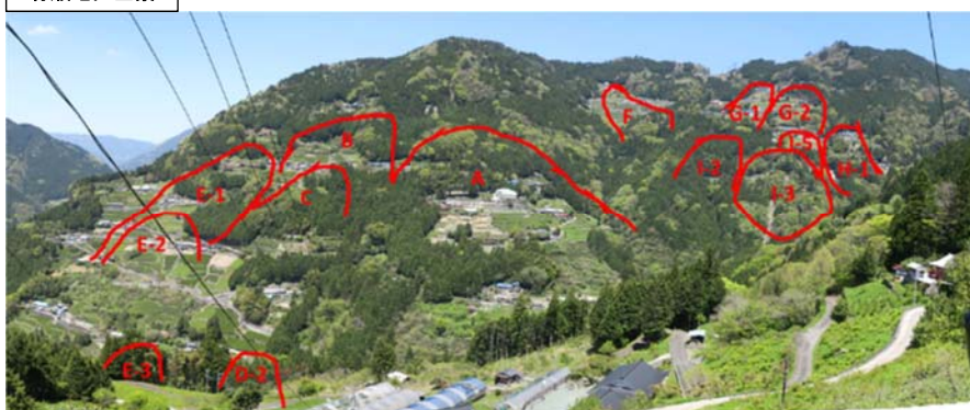
有瀬地区全景
