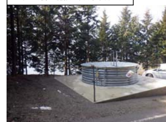
地すべり防止施設の例(集水井工)
