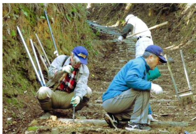
▶ 遍路道の改修作業
